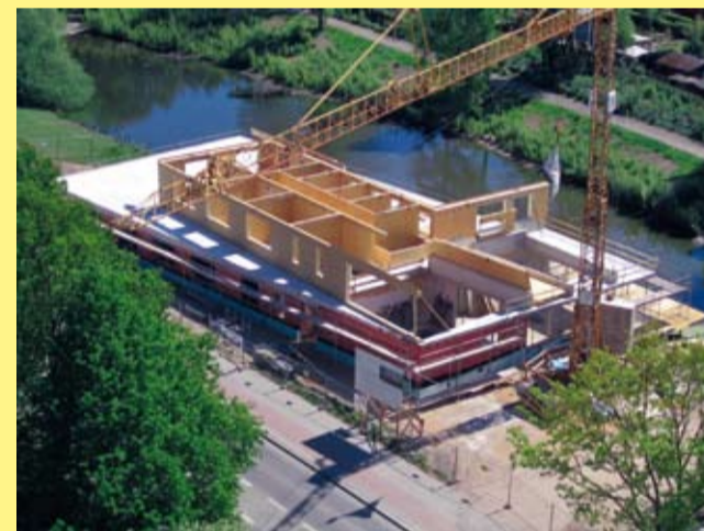
Das Haus im Rohbau, 2011 (Foto: Jörg Meyer) ▲
